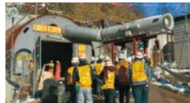
高速道路 施工現場見学
